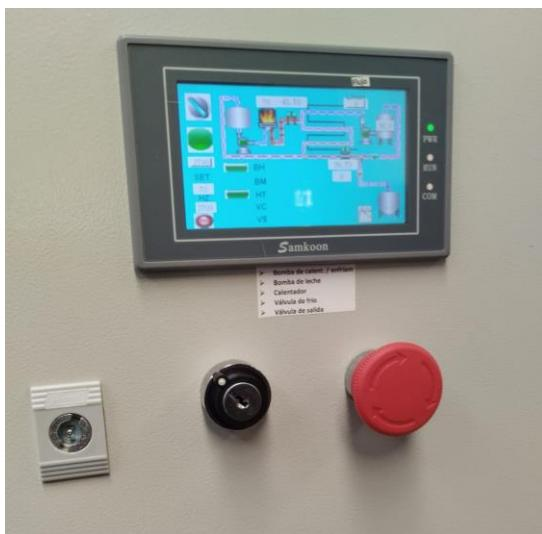
Este módulo cuenta con un tablero con certificación IP 65, adopta la tecnología para que la máquina de pasteurización se controle en 2 modos: manual y automático, cuenta con pantalla touch de 4.3 pulgadas, con sistema PID.
